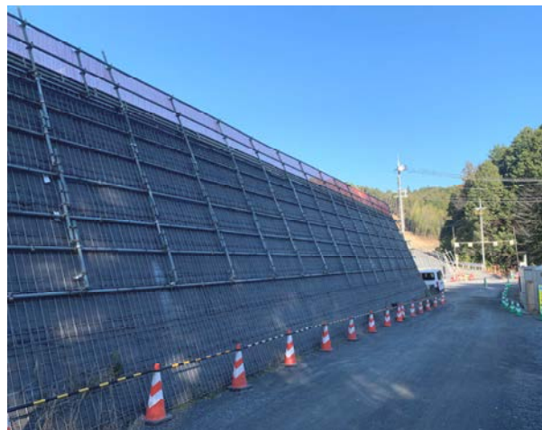
写真-1 ワイヤーウォール工法全景
