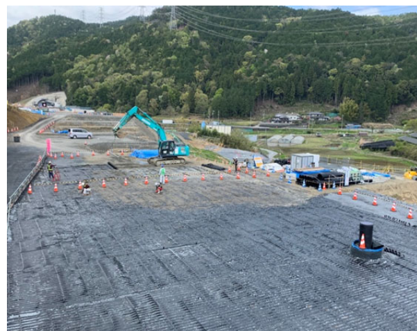
写真-2 敷網設置状況
