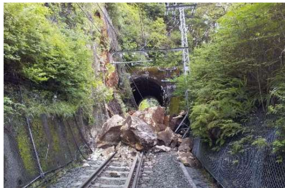
写真-1 被災時の状況
