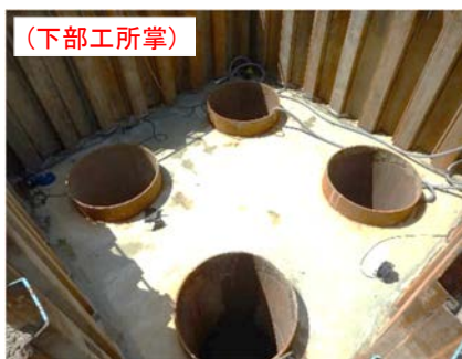
写真－3 回転杭完了時
