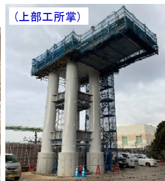
写真－4 鋼管集成橋脚完了時
