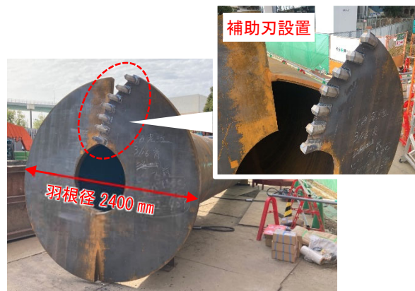
写真－1 杭先端羽根部 補助刃設置
