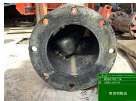
写真 2 玉石によるロッド管閉塞
