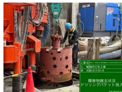
写真3 ドリリングバケット使用状況
