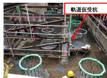
写真5 軌道仮受杭近接
