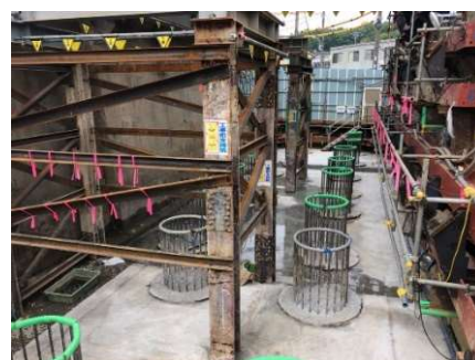
写真6 場所打ち杭施工完了
