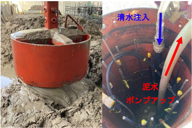
写真-1 スライム処理状況 写真-2 水置換状況
