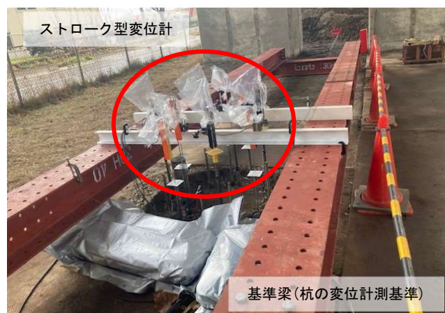
写真-3 先端載荷試験状況
