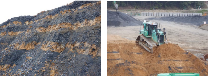
図 2 スtockパイル切り崩し断面と混合状況
