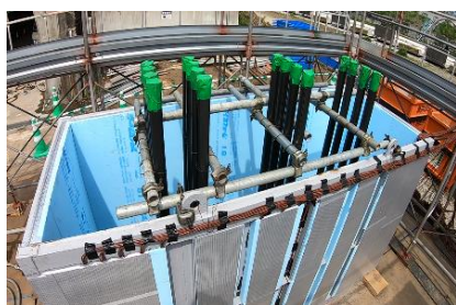
写真-1 測温管用外管設置状況
