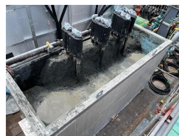
写真-3 掘り出した凍土
