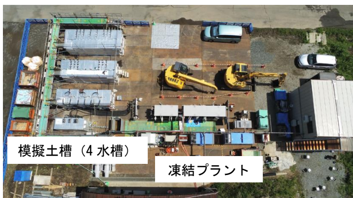
写真-2 実証実験ヤード全景
