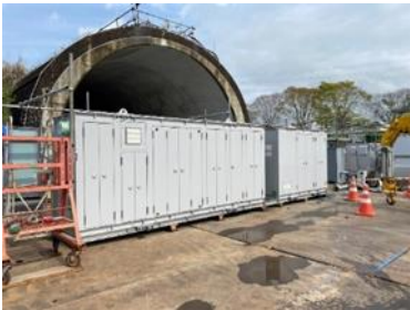
写真-4 冷凍設備設置
