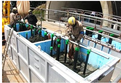
写真-5 水槽内土砂投入・締固め
