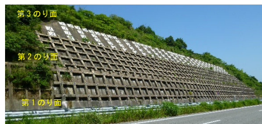
図-2 山陽道⑥全景写真
