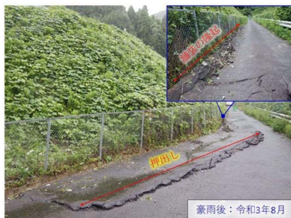
図-1 令和3年8月豪雨の影響による舗装の隆起
