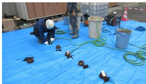
写真－1 注入状況
