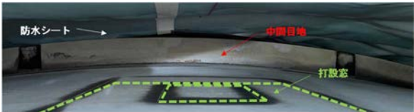
図-7 中間目地セット状況
