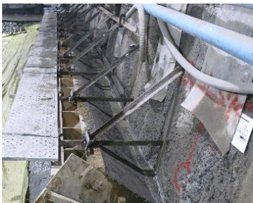
写真 1 打継ぎ目の構造
