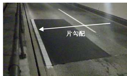
写真2 応急補修状況
