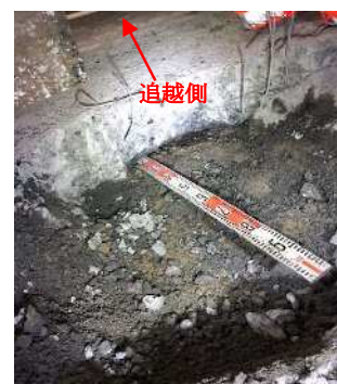
写真3 コンクリート版切削状況
