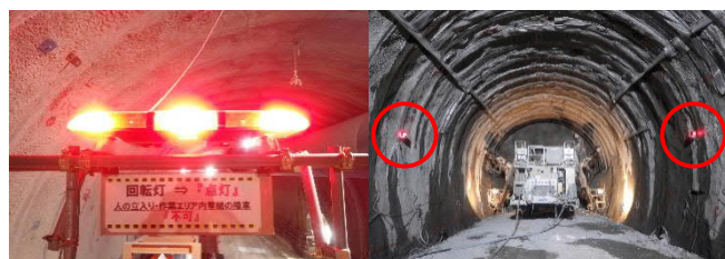
写真-2 大型警告灯(左)及び回転灯(右)
