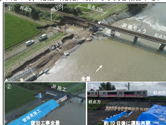
図 1 災害時及び運転再開時の状況（2022 年 8 月）
