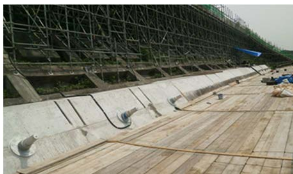
図-2 仮設グラウンドアンカー工
