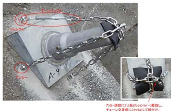
図-1 頭部落下防止対策工
