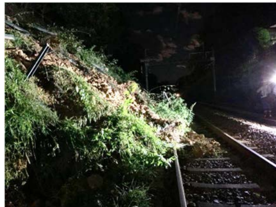
図-1 鉄道切土斜面の土砂崩壊
