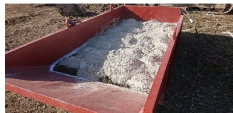
(a) 土の計量と粉体の投入
