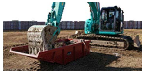
(b) バックホウによる混合
