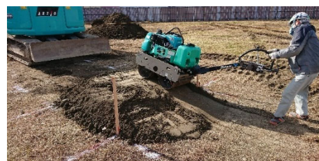
(c) 振動ローラによる転圧
