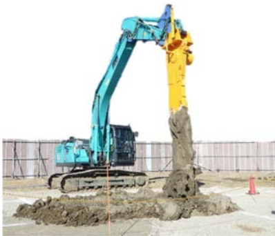
図 5 実機による改良体造成状況
