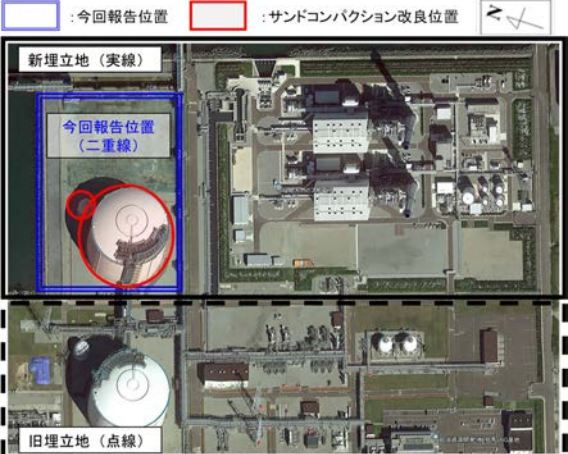
図-1 相馬 LNG 基地および福島天然ガス発電所
