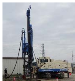
図-1 GI 機及び鉛直変位計測版設置状況
