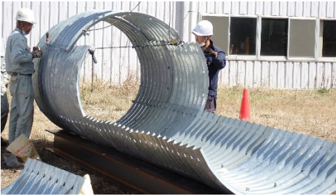
写真-5 実大施工性確認試験
