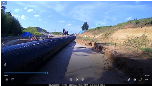
写真-4 施工状況 トップセクション設置完了時
