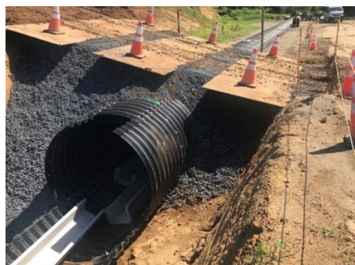
写真-1 コルゲートパイプ設置状況
