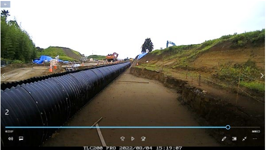
写真-3 施工状況 サイドセクション設置完了時
