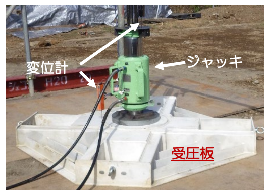
写真 1 引抜き試験状況
