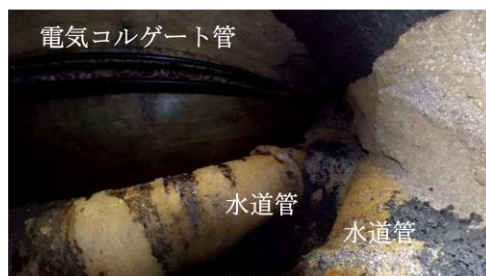
図-4 空洞内の様子
