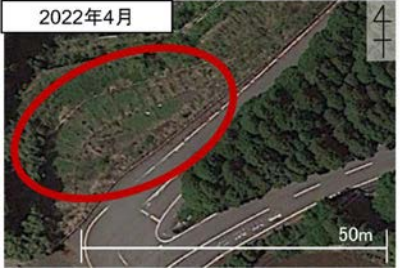
図-3 補強土擁壁の衛星写真(2022)
