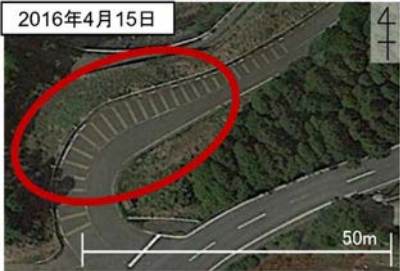
図-2 補強土擁壁の衛星写真
