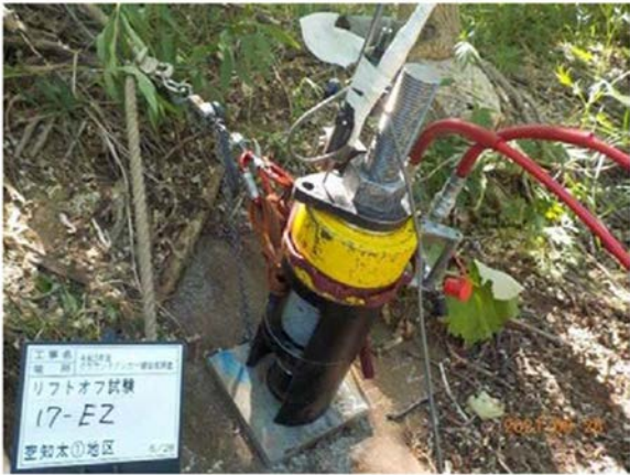
写真－1 リフトオフ試験
