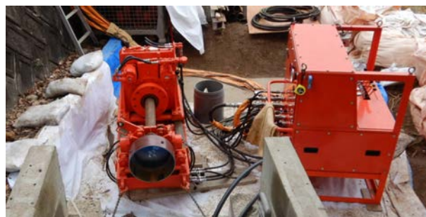
図-6 管挿入機械（ボーリングマシン）
