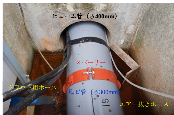
図-5 塩ビ管挿入状況
