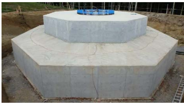
図1 風車基礎全景
