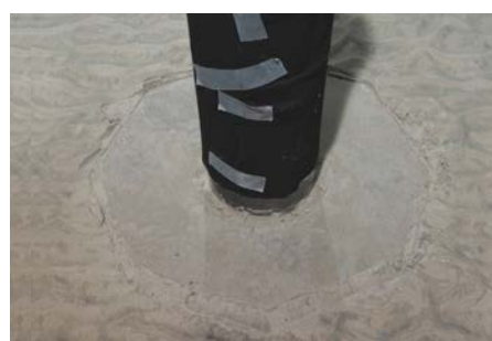
写真－8 AsMat を撤去した状況
