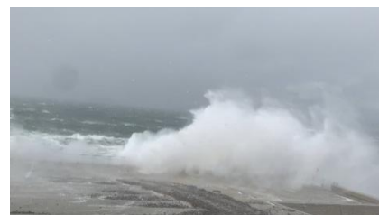
写真-1 直立護岸での越波の例
