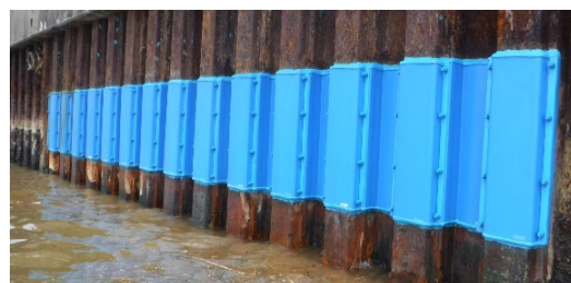
図 2 実環境下暴露試験状況
