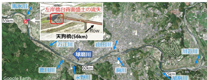
図-1 球磨川の 55km~67km 区間の航空写真と天狗橋(56km)の被害状況
