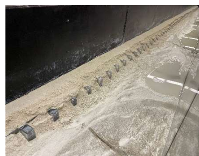
図 8. 試験後の試験体全体
