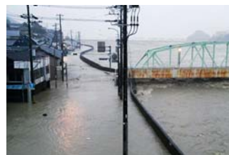
図-2 紀伊半島大水害の被害 (出典：国土交通省近畿地方整備局)
