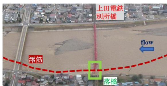
図-1 令和元年東日本台風による千曲川・上田電鉄別所橋落橋の様子(撮影日: 2019/10/13 9:31)
