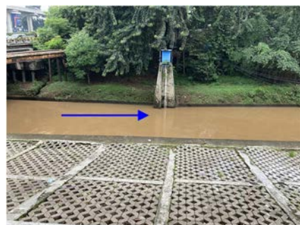
写真-1 MT. Haryono 水位観測所の様子 (2022 年 2 月 18 日、平常時)
