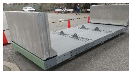
写真-1 鋳鉄床版の架設ブロック
