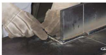
(a) 止端仕上げ
