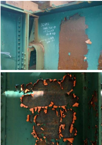
図－3 黒皮鋼板と鉛丹さび止め
