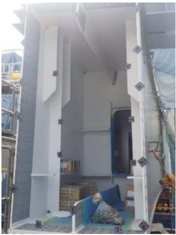
図-3 ターゲット貼付状況
