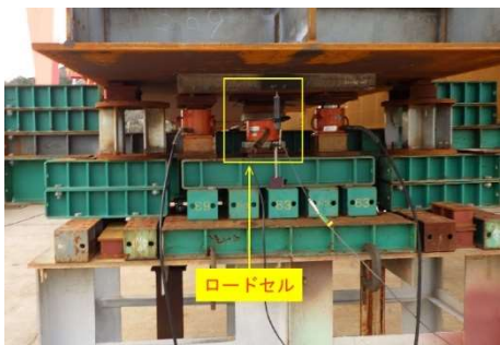
写真-2 ロードセル設置状況
