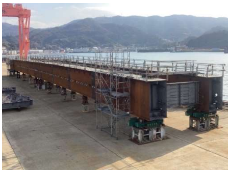
写真-1 仮組立状況
