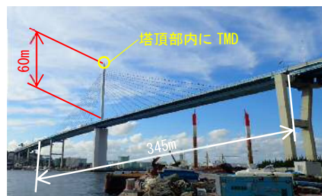
写真 1 荒津大橋 TMD 設置位置
