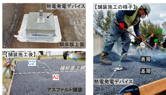
図-8 埋込型熱電発電デバイスの鋼床版橋梁への設置
