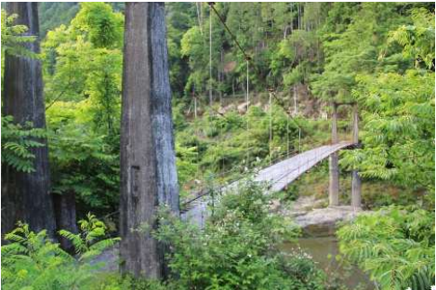
写真-1 無補剛小規模吊橋
