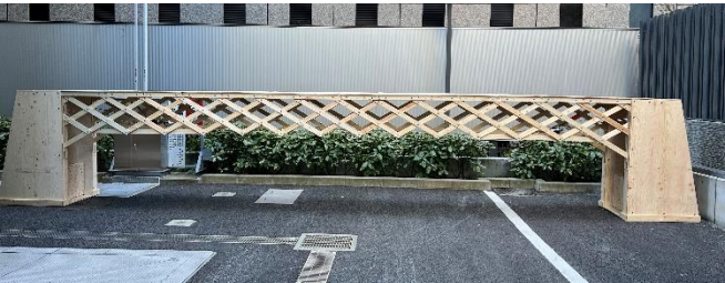
写真-1 伸縮式ラティストラス構造
