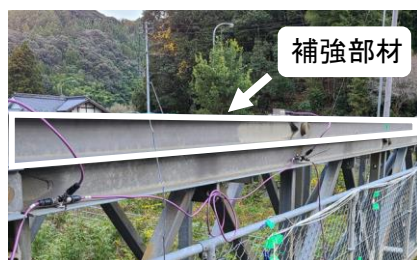
写真2 主構上部の補強部材
