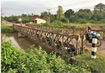
写真1 モジュラー型仮設橋
