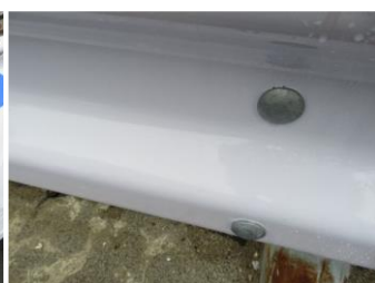
写真9 貼付後の外観
