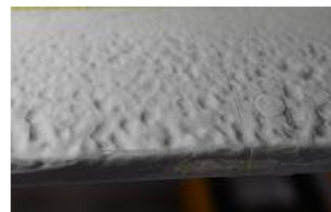
写真4 空貼り（凹凸部）
