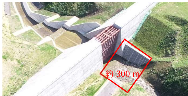
写真-4 砂防堰堤背面状況
