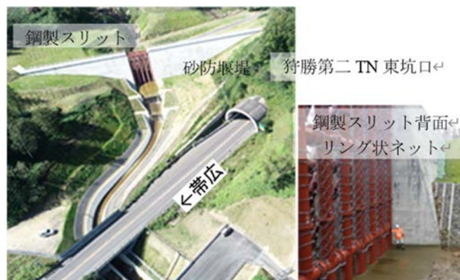
写真-3 狩勝第二トンネル付近の砂防堰堤
