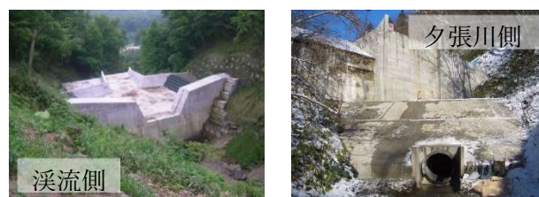
写真-2 栗山トンネル中間部の砂防堰堤
